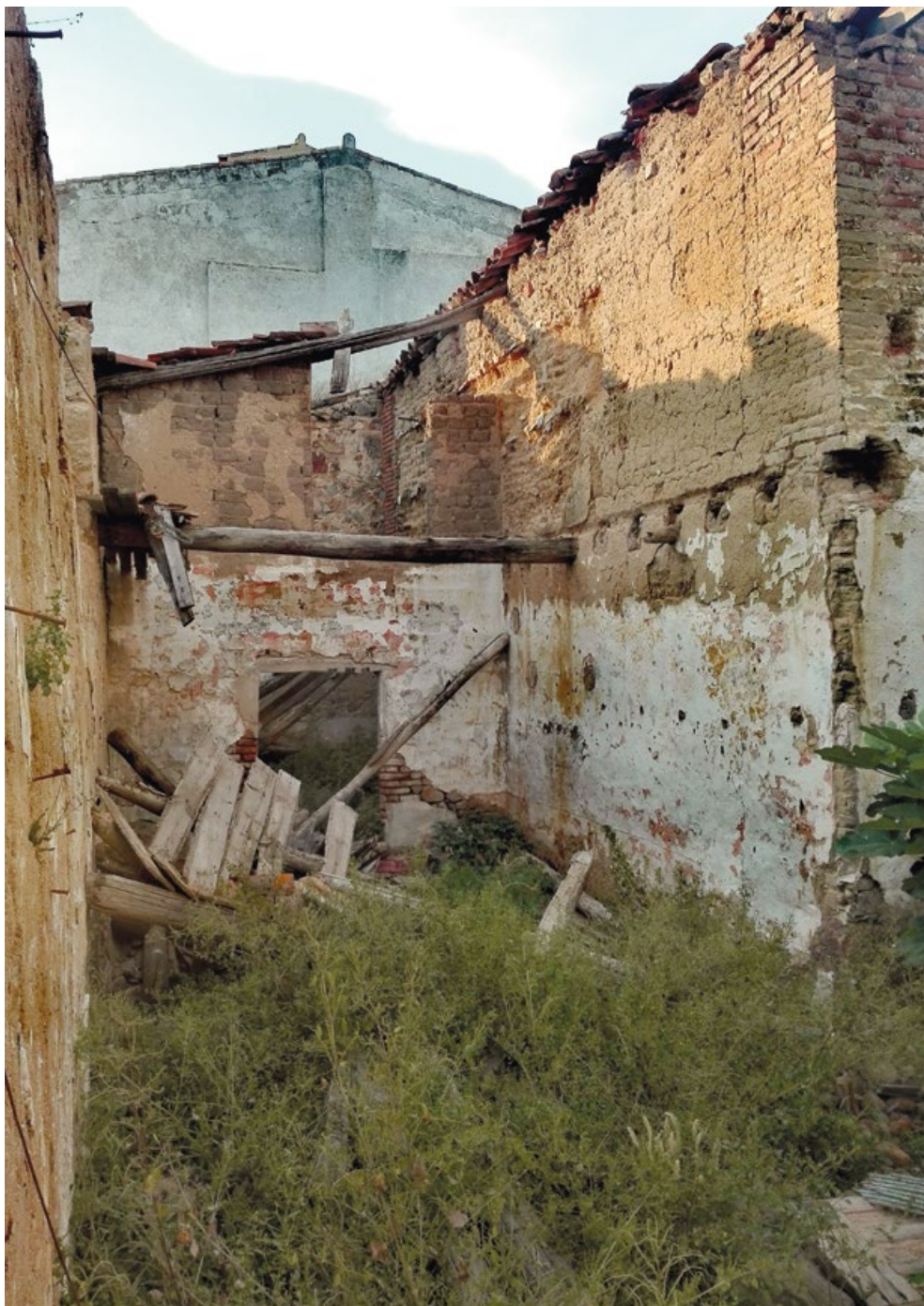
Edificación en tierra cruda con diferentes técnicas constructivas de tapia y adobe. Interior. Guillena, Sevilla, 2020. Foto: Arturo Jiménez Viera
