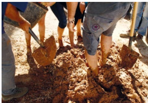
Plástico, mortero para adobe, albañilería, enfoscado base, etc. Sevilla, 2019
