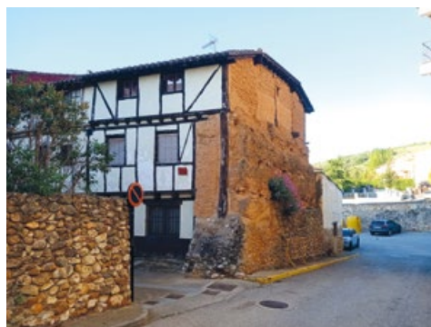
Estructura-cerramiento de entramado de madera relleno por mampostería de adobe. Covarrubias, Burgos, 2021
