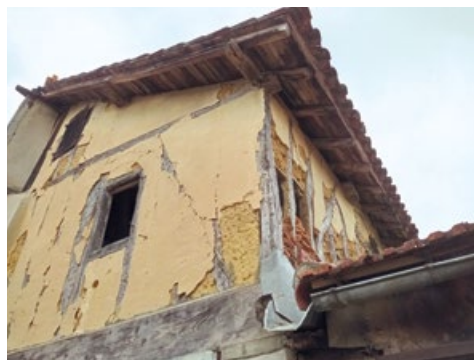
Estructura-cerramiento de torchis o entramado de madera, ramas y mortero de tierra y fibras vegetales. Región de Languedoc, Francia, 2022
