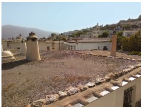
Impermeabilización de cubierta plana mediante tierra arcillosa procedente de rocas de pizarra. Pitres, Granada, 2021. Fotos: Arturo Jiménez Viera
