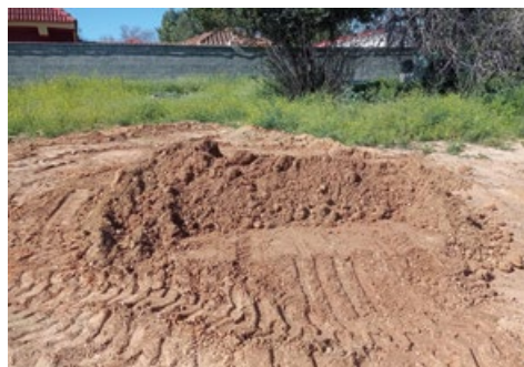
Semisólido, hormigón de tierra para muro de tapia. Palomares del Río, Sevilla, 2023
